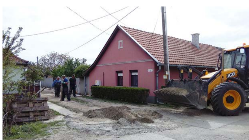
A Katona utca vízelvezetésének újraépítése
