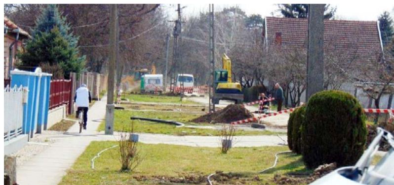
Felújítási munkálatok a Sport utcában
