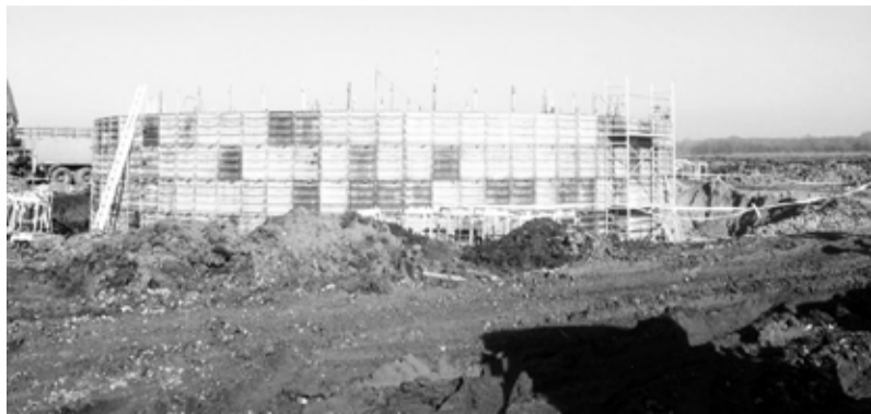
A szennyvíztisztító telep medencéjének építése
