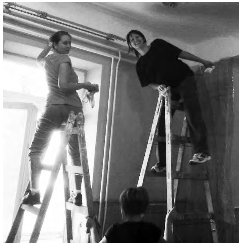
A nyári karbantartási szünet alatt 2 fürdőszobát és 3 csoportszobát, illetve az előteret varázsolták újjá a Gondozási Központ Bölcsőde dolgozói. A festési munkákat szakavatott kezek végezték a közmunka program keretében. Nagy Judit intézményvezető megköszönte a közmunkásoknak a gyors és szép munkát.
