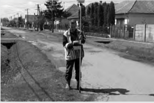
Megkezdődtek a geodéziai felmérések a szennyvízberuházással kapcsolatban
