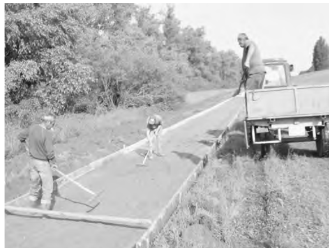
Szanazugban betonút vezet majd a komphoz. A munkálatok idén áprilisban kezdődtek, ugyancsak pályázati pénzből. A csapadékos időjárás miatt a pályázatkezelő július végéig hosszabbította meg a befejezési határidőt. A napokban elkészül a betonozási munka, és július első hetére marad a padkarendezés.
