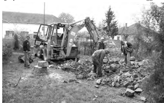
Megkezdődött a tér kialakítása a Dobó utcai óvoda előtt. A felújított parkot a tervek szerint 2010 augusztusáig adják át.
